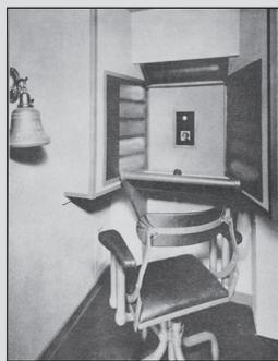
VIDEOTELEFONZELLE zur Demonstration aus dem Jahr 1922 im Bell Telephone Magazine.
