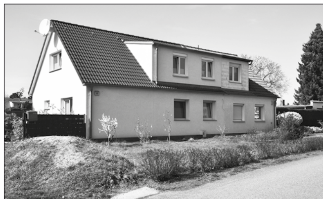
SIEDLERHAUS in der »Neuen Heimstatt«.
