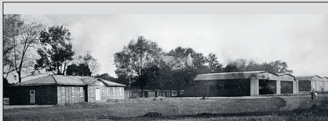
HANGARS und Verwaltungsgebäude.
