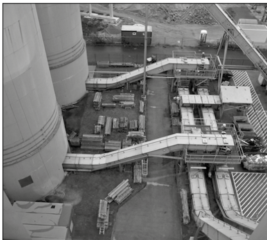
HOLZSCHNITZELHEIZKRAFTWERK. Foto: mr
